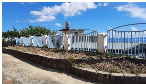
說明：施工中-斑馬駱駝泥塑拆除
