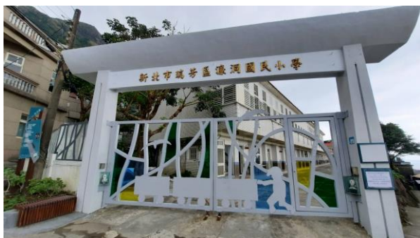
說明：施工後-校門
