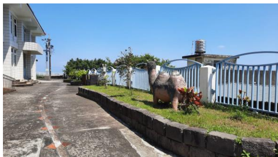
說明：施工前花台
