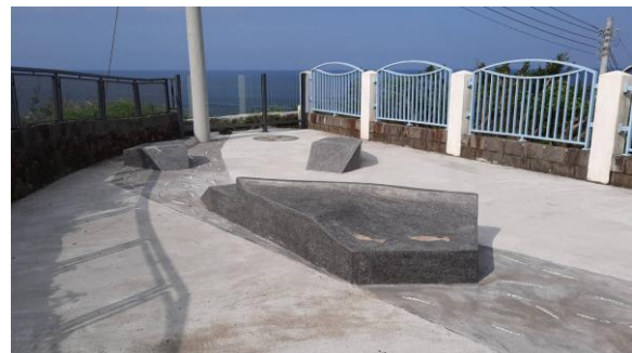
觀景台-施工後
